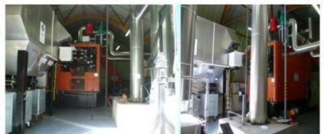
Chaudière Weiss 1,2 MW avec électro-filtre pour traitement des fumées
